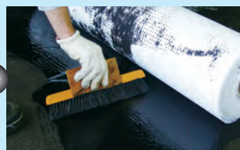
●ハルPCマットの流し張り
