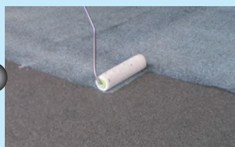
●プライマーの塗布
