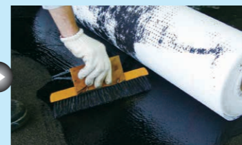
●ハルPCマットの流し張り
