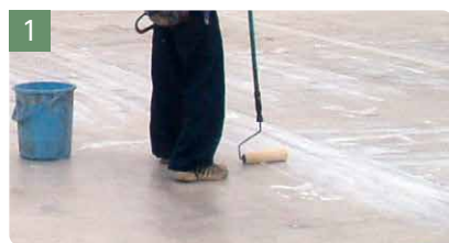
1 プライマー塗布
