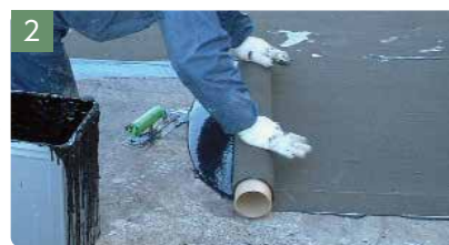
3 ハルレコート/ハルレシート流し張り
