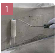
プライマー塗布
