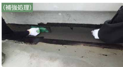
(補強処理) 2 ハルレコート/ハルレシート200張付け
