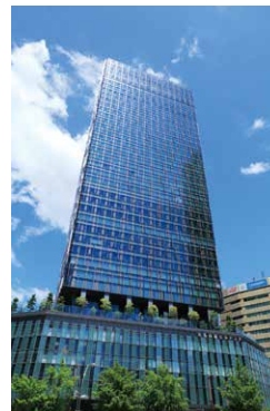
大名古屋ビルヂング
