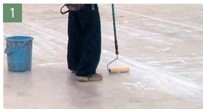
プライマー塗布
