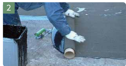
ハルレコート/ハルレシート流し張り
