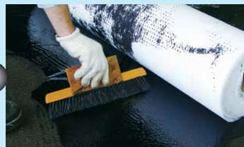
●ハルPCマットの流し張り
