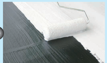
●保護層の施工
