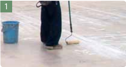
プライマー塗布
