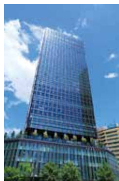
大名古屋ビルヂング
