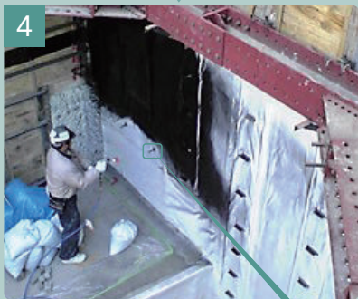
4 スプレイジョンS吹付け スプレイジョンSを均一に吹付ける。 ねじ込み式セパ受け金物 (別途工事)
