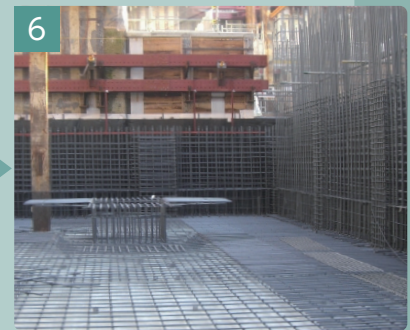
6 底盤部保護モルタル打設、配筋
