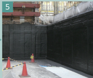
5 スプレイジョンS吹付け完了
