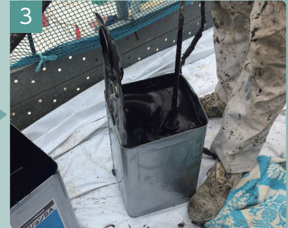
3 材料の攪拌 スプレイジョンSAを攪拌しながらスプレイジョンSBを添加し、約10秒間均一に攪拌。その後攪拌しながらスプレイジョンSZを添加し、約40秒間攪拌混合する。
